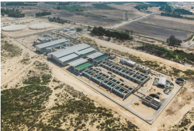
海水脱塩システムプラント
